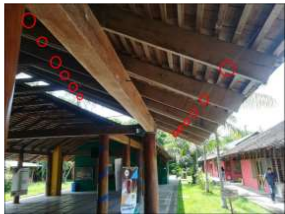
Apuntalamiento costado occidental 12 puntos
