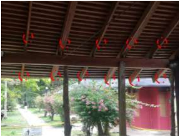
Apuntalamiento costado oriental 12 puntos
